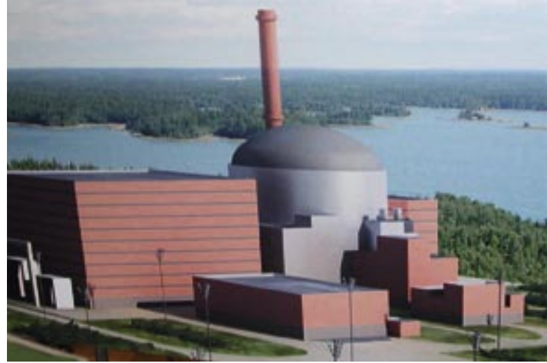
EPR Tekening van de eerste European Pressurised water Reactor met een vermogen van 1600 megawatt, die komende jaren in Finland gebouwd wordt.
